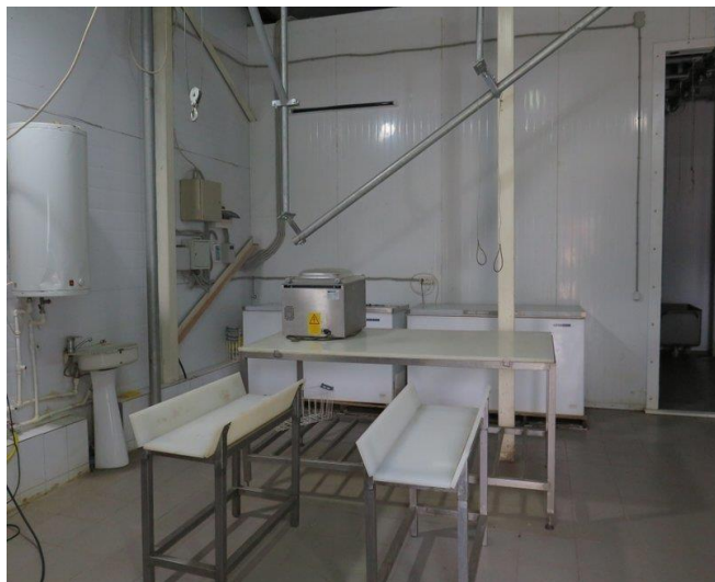
Rysunek 44: zamknięte, dobrze wyposażone pomieszczenie do obróbki
